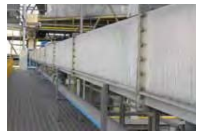
Canaletta di fluidificazione polveri
